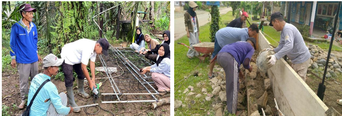
Gambar 6. Pembuatan kerangka huruf dari besi sebagai penyangga ecobrick
