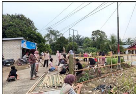
Gambar 5. Kegiatan Pemasangan Pagar
