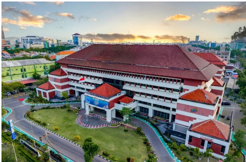
Gambar 4. Kantor Perumda Air Minum Surya Sembada Kota Surabaya
